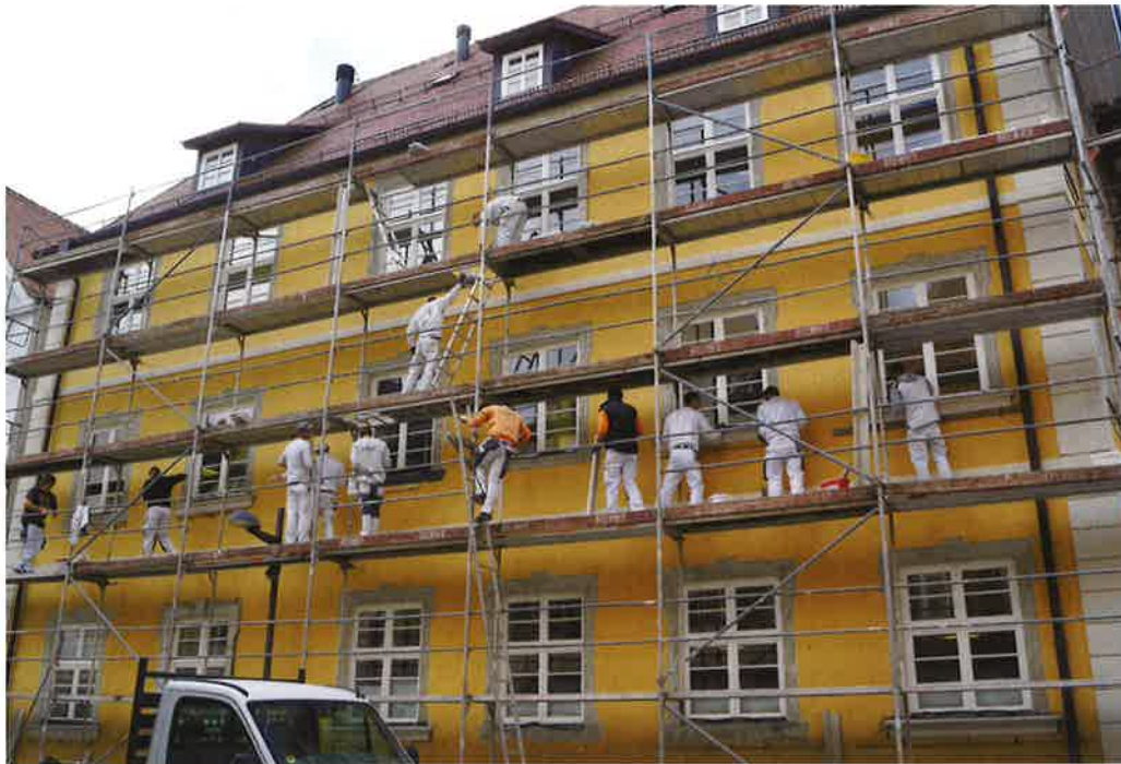
1 An der barocken Fassade in Ellwangen konnten 26 angehende Stuckateurmeister Praxiserfahrungen bei der Stuckerneuerung sammeln.
