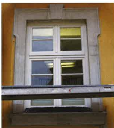
2 Insgesamt 49 Fenster erhielten eine neue Stuckeinfassung.
