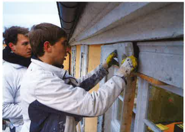
3 – 5 Das Anbringen und Beiputzen der Stuckformteile übernehmen die Meisterschüler der Bundesfachschule für Stuckateure Heilbronn.
